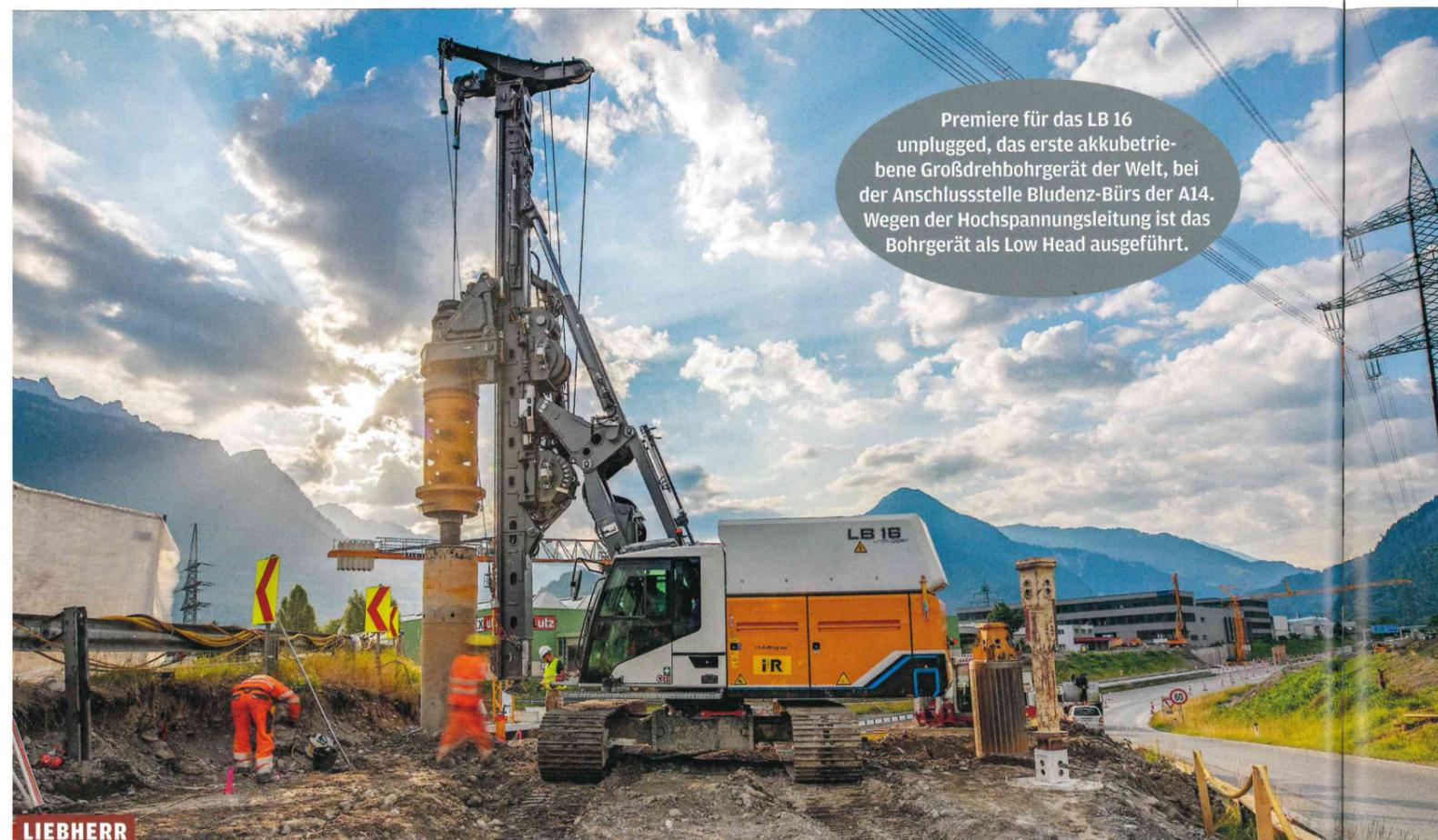
Premiere für das LB 16 unplugged, das erste akkubetriebene Großdrehbohrgerät der Welt, bei der Anschlussstelle Bludenz-Bürs der A14. Wegen der Hochspannungsleitung ist das Bohrgerät als Low Head ausgeführt.
